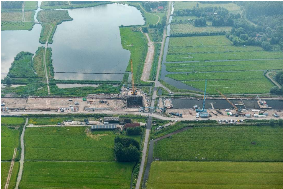
Luchtfoto van de Zuidbuurt met de werkzaamheden aan de Hollandtunnel juni 2021.
