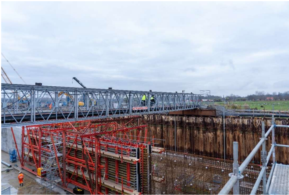
Fietsbrug over de Hollandtunnel.
