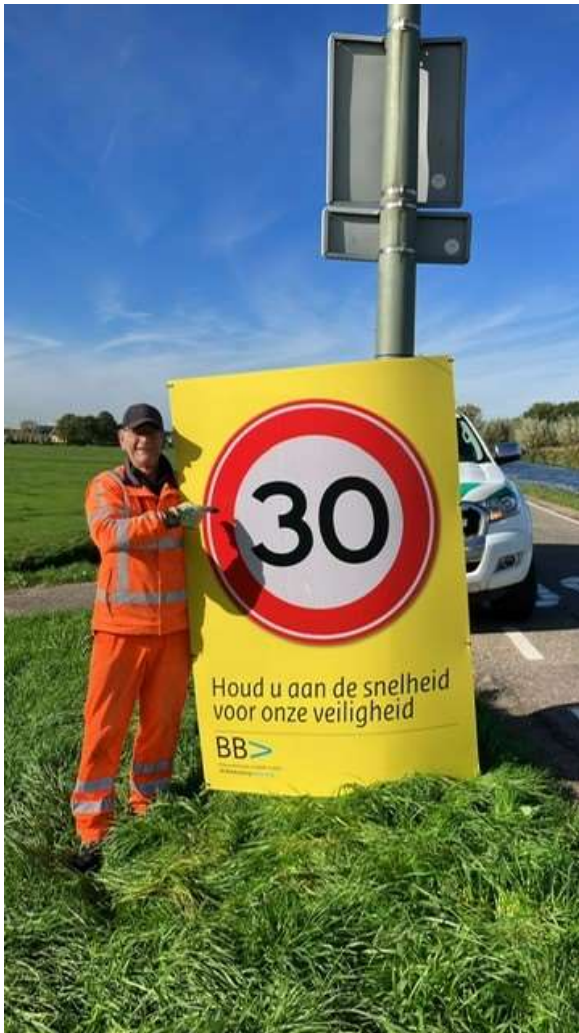
Gebiedsconciërge Herman plaatst extra verkeersborden aan de Zuidbuurt.
